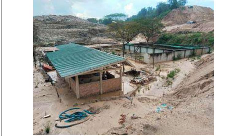
Gambar 3.19 Instalasi Pengolahan Limbah (IPL)
