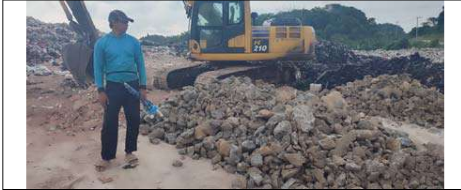
Gambar 3.21 Pembelian batu untuk pengerasan jalan
