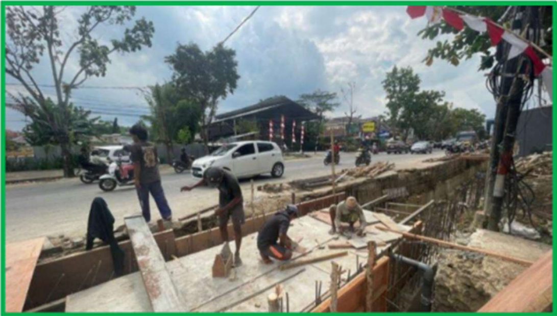
Gambar 4. 9 Perbaikan Drainase di Samarinda
